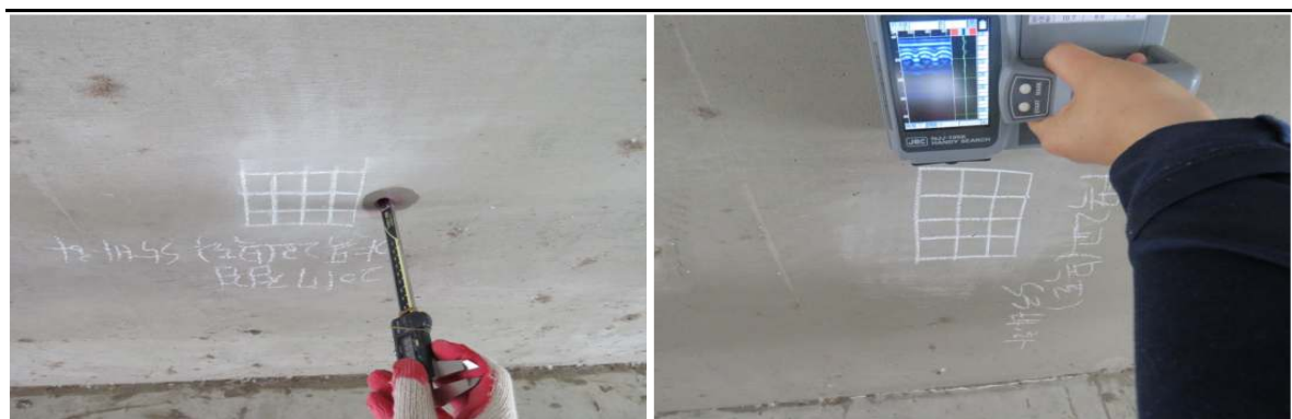
<그림 3.3.3> 탄산화 깊이 및 측정위치별 철근탐사 조사 현황
