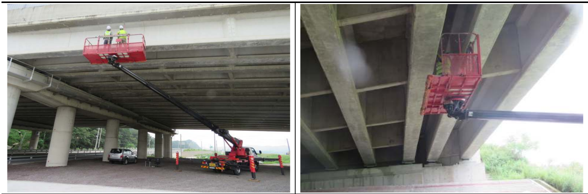
〈그림 3.1.1〉 근접장비를 이용한 현장조사 현황
